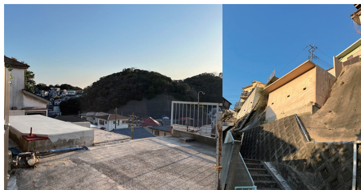
二葉2丁目空家解体現場
